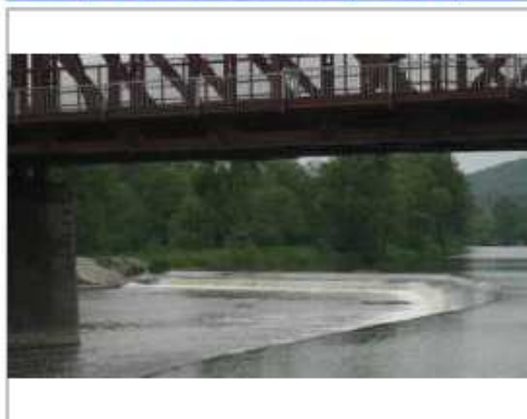
Detail pravého břehu se skluzem pro vodáky
