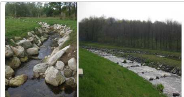
Obr. 2: příklady rybních přechodů typu bypas
